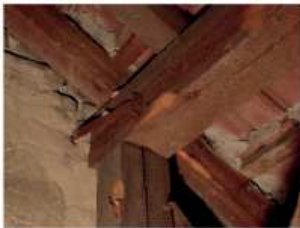
01_D Stuhlwandanschluss
