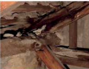
01_A Dachbalkenanschluss
