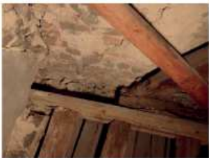
01_A Deckenbalkenanschluss
